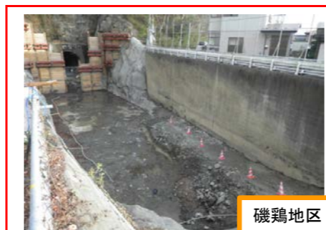
③施工：森本組
