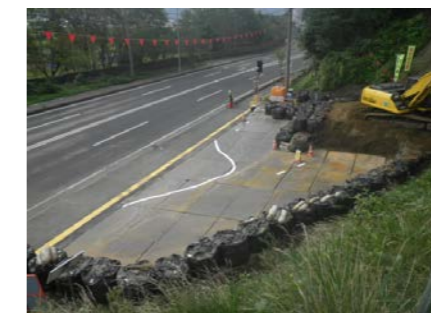
▲敷鉄板の設置
